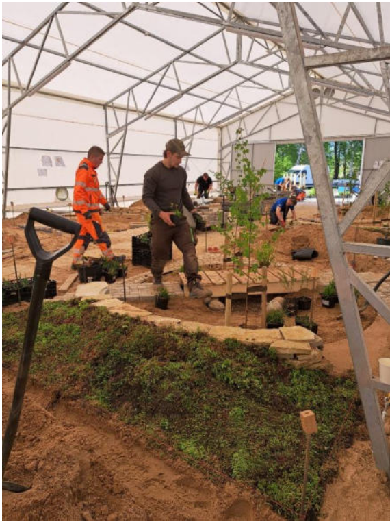
Thore und Fabian beim Fertigstellen der Baustelle
